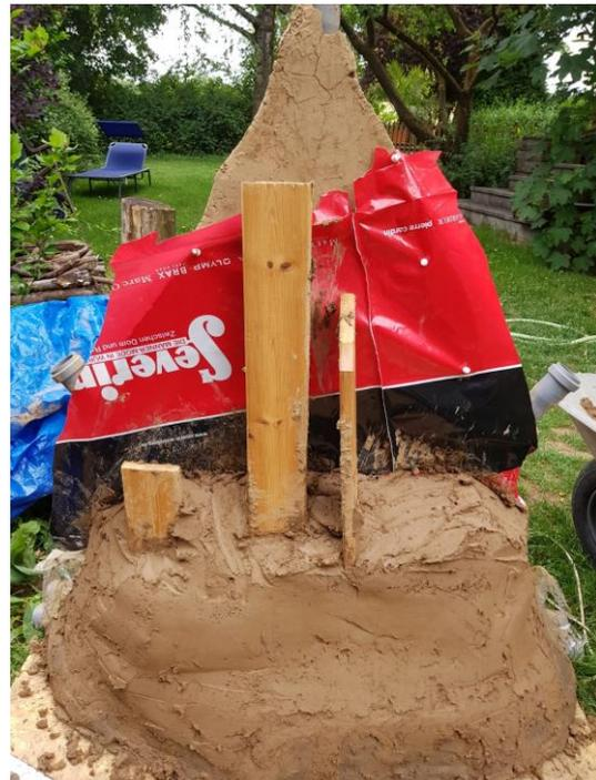
**Abb. 5:** Der zweite Teil ohne Rohre mit stabilisierenden Hölzern
